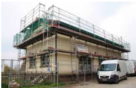
La halle marchandises durant les travaux (oct. 2015)
