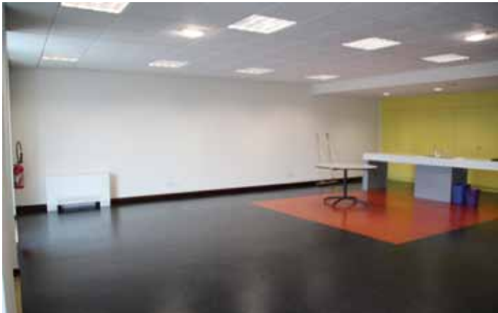
Le local A avant l'installation du RAM
