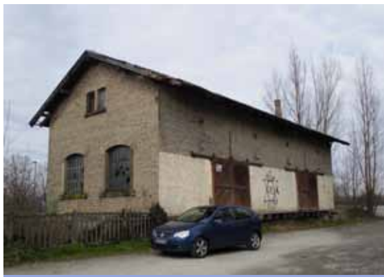
La halle marchandises avant les travaux
