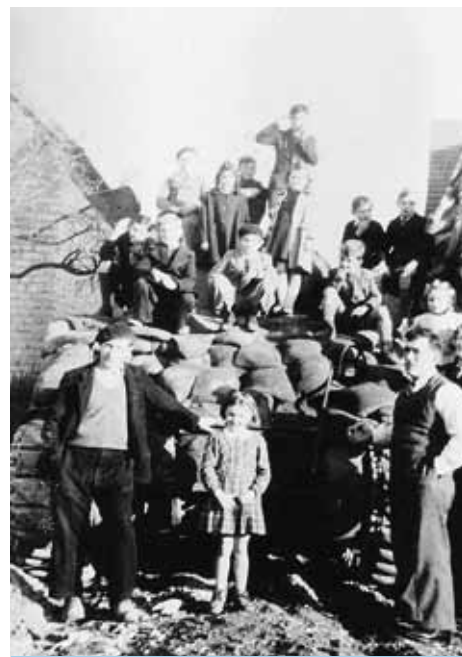
Char à l'affût près du pont
