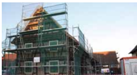
Logements aidés, rue des Héros Février 2014
