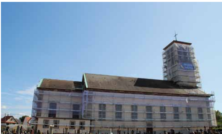
L'église Saint-Wendelin au début des travaux de peinture (août 2015)
