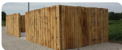
L'habillage de containers Domaine du Golf et Schlag
